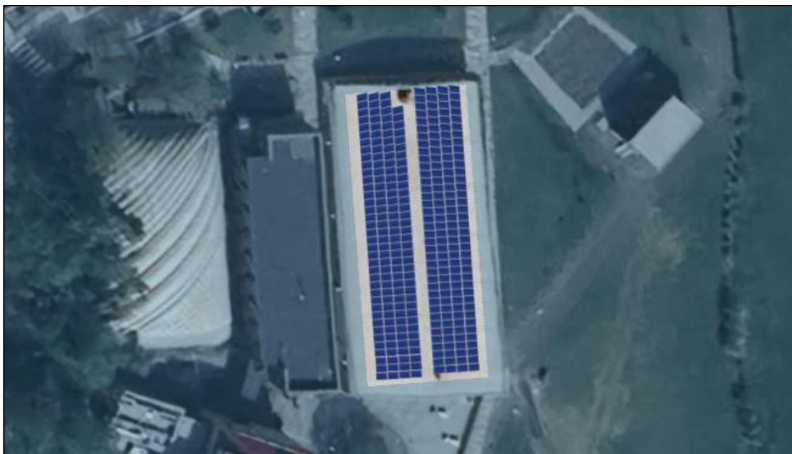
Obrázek 3 Instalace FVE na střeše sportovní haly
