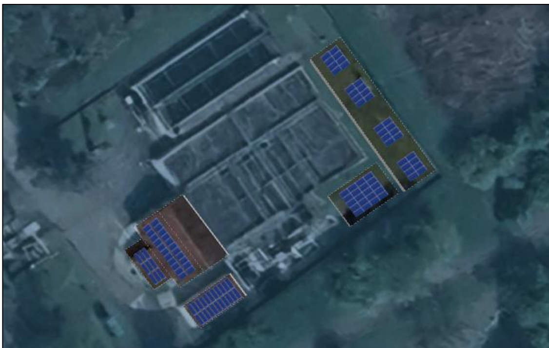
Obrázek 1 Instalace FVE pro objekt čistírny odpadních vod
