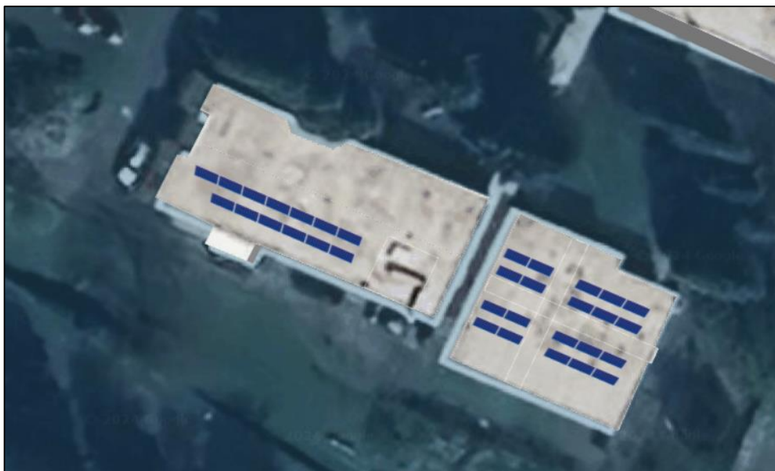
Obrázek 6 Instalace FVE na střeše MŠ Karlická
