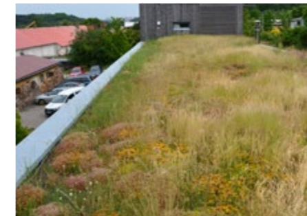
extenzivní zelená střecha s travinami, lišejníky a rozchodníky
