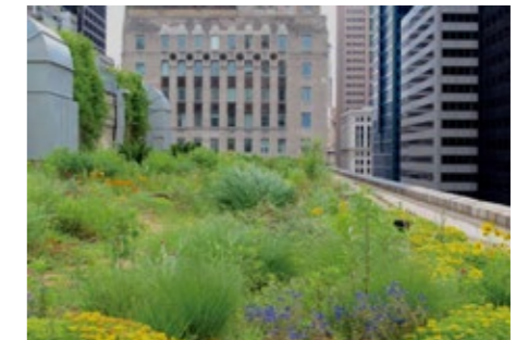
intenzivní zelená střecha s bylinami a cibulovinami
