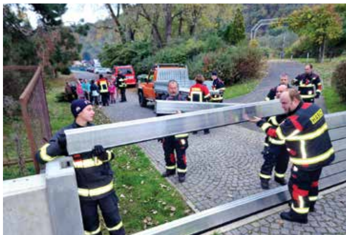
-- Cvičná výstava protipovodňové zábrany v ulici Na Drahách --
