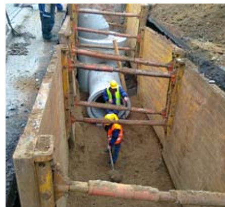
– V části ulice od Masopustního náměstí k železničnímu přejezdu se ještě dělá nová dešťová kanalizace. –
