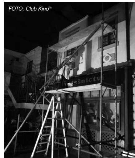
– Takhle probíhala rekonstrukce Club Kina. –
