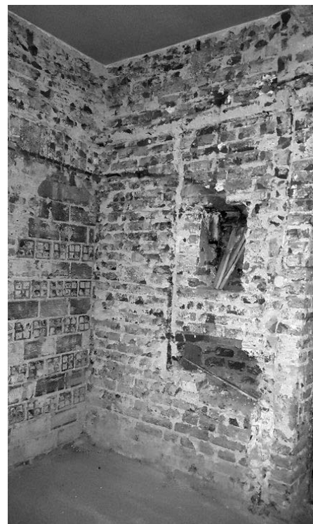
– Dozdívky z dutých cihel ve střední nosné zdi. –
