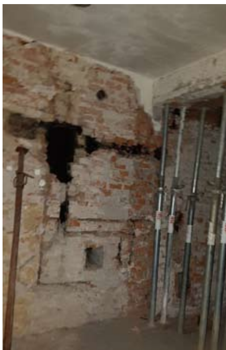
– Havarijní stav komínového zdiva vnitřních stěn, do kterého byly již při výstavbě domu naprosto nevhodně vloženy hlavní nosné železobetonové průvlaky nesoucí stropní konstrukci. Dům takto řadu let stál, ale v rámci rekonstrukce se pod takový stav hlavních nosných stěn žádný statik nepodepíše. –
