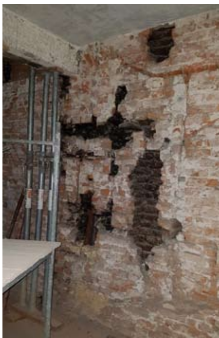
– Havarijní stav komínového zdiva vnitřních stěn, do kterého byly již při výstavbě domu naprosto nevhodně vloženy hlavní nosné železobetonové průvlaky nesoucí stropní konstrukci. Dům takto řadu let stál, ale v rámci rekonstrukce se pod takový stav hlavních nosných stěn žádný statik nepodepíše. –
