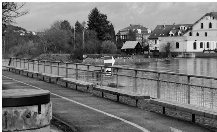
– K procházce a posezení láká nové prostranství u černošického jezu – posunem zábradlí se výrazně rozšířil veřejný prostor podél cyklostezky s výhledem na řeku a jez s rybochodem. –
