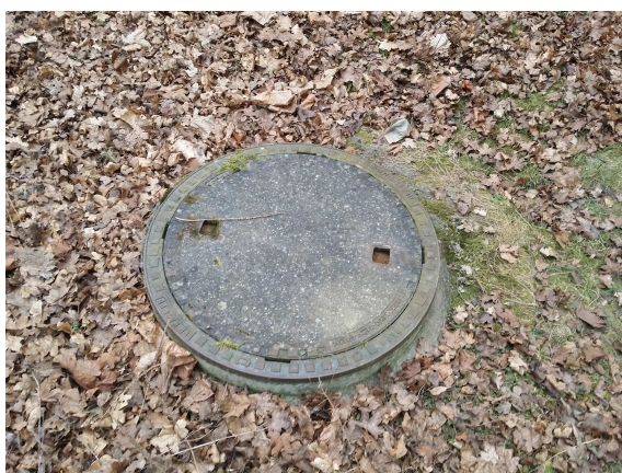
obr. Odstraňovaná kanalizační šachta
