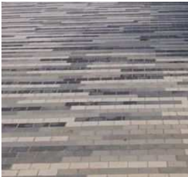
obr. skladebná dlažba v nepravidelných pásích
