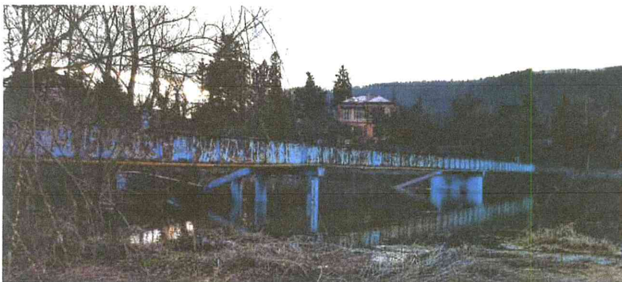
Obr. 3.1 – Konstrukce lávky pro pěší přes řeku Berounku v Černošicích
