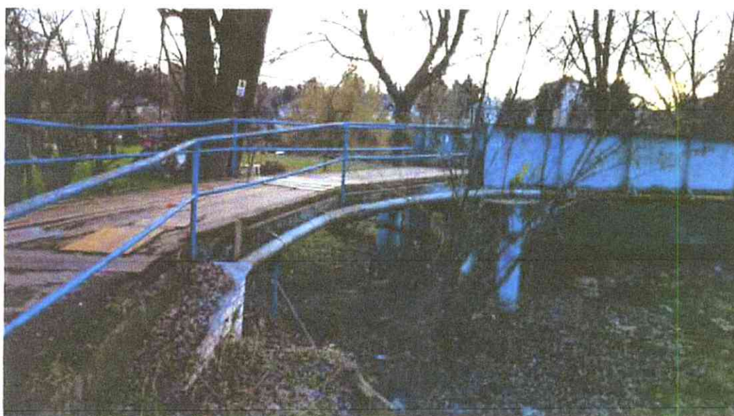
Obr. 3.2 – Přístupová rampa ve směrovém oblouku
