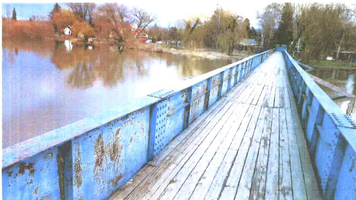
Obr. 3.3 – Dřevěná konstrukce mostovky lávky pro pěší
