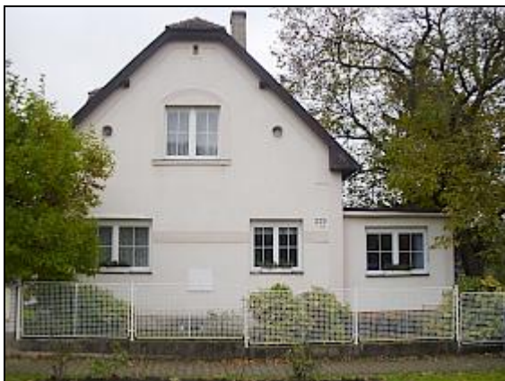
Bod 1, Ke Zděři 279-39 Radotín
