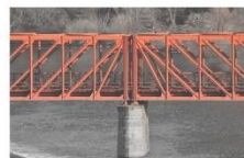
Konstrukce mostku bude na místě rozřebrána a dopravena po železnici na kamenný most, potom bude předtlačena a dovedená na konečné místo.
