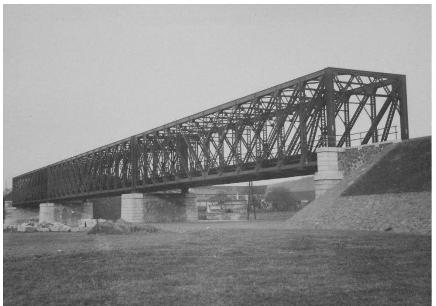
shora: původní jednokolejný most, stavba dvoukolejného mostu, nový most po dokončení v roce 1911 (zdroj: archiv NTM v Praze)
