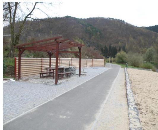
prostor pláže po dokončení
