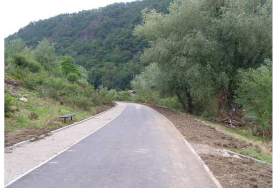
úsek Pod Hladkou skálou po dokončení
