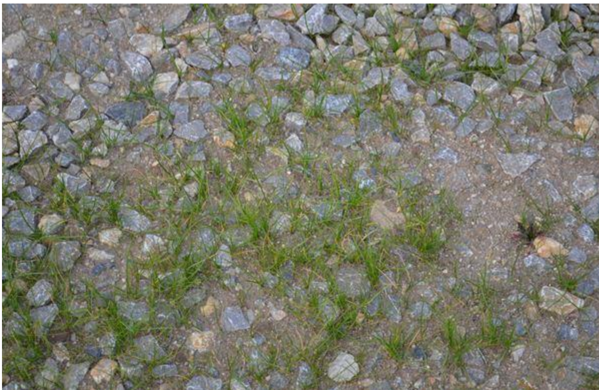
Obr. č. 8 Vzcházející porost štěrkového trávníku
