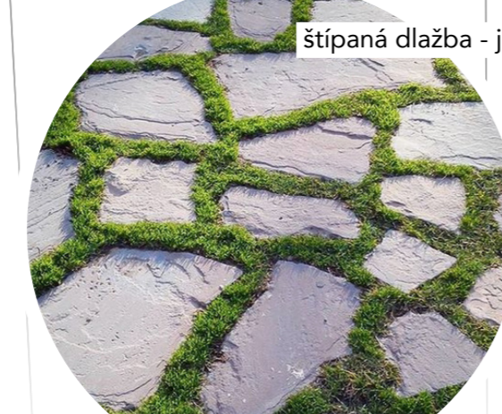
štípaná dlažba - jednotná pro chodníky i nástupiště
